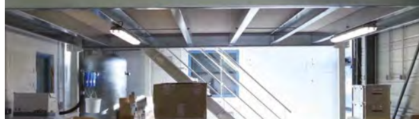
Installation d'un bureau au-dessus d'un atelier de production pour répondre à un accroissement d'activité sans devoir déménager (Absices)
