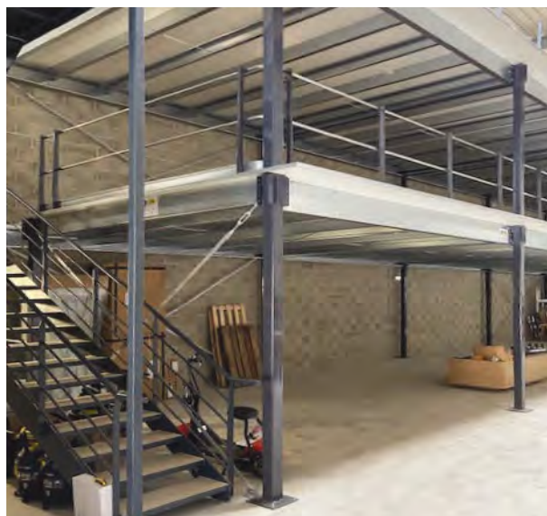
Double plateforme avec accès aux 2 niveaux, espacés de moins de 40 m conformément à la norme pour faciliter l'évacuation en toute sécurité (GBG Concept)
