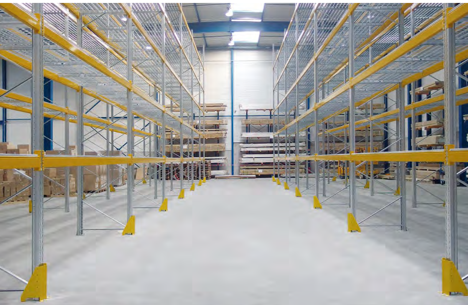
Installation avec platelages caillebotis pour entrepôt équipé de têtes de sprinklage (Adetech)
