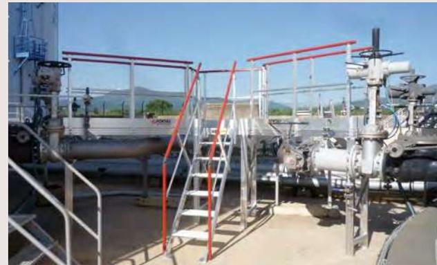
Échelle à marches à palier pour passage au-dessus de tuyauteries et accès aux vannes
