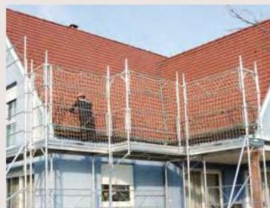
Dernier niveau couvreur avec console de déport, montant 2000 et garde-corps standard avec filet
