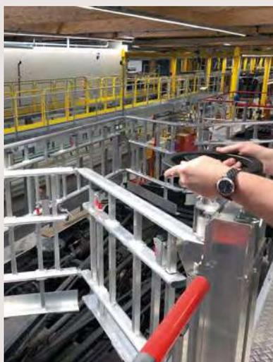
Volant de manœuvre pour ouverture/fermeture des garde-corps
