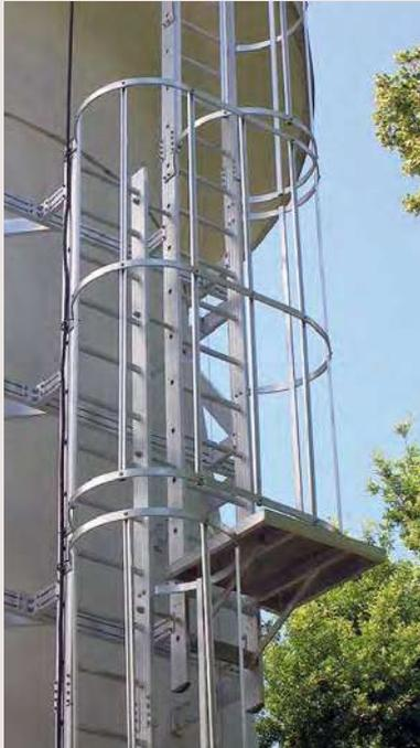
Échelle à crinoline montant renforcé pour accès en toiture d'un château d'eau
