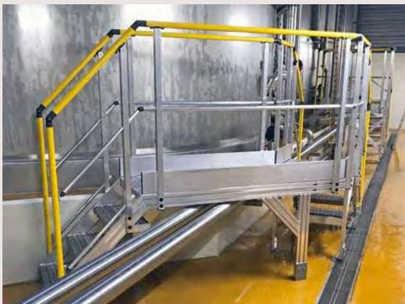
Plateforme pour passage de tuyauteries dans site de stockage
