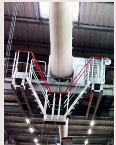
Ensemble échelle à marche à palier pour passage sous aérateurs dans une unité de conditionnement
