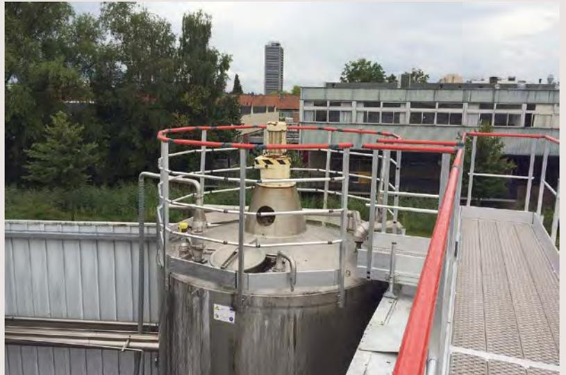
Garde-corps en kit composé d'une main courante, d'une lisse intermédiaire et d'une plinthe, après mise en place sur la cuve
