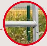
Barreaux antidérapants Ø 48 mm assemblés par soudure haute résistance
