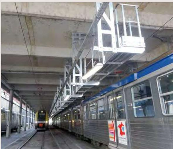
Passerelle de maintenance suspendue de 110 m de long pour accès en toiture des trains - Technicentre SNCF
