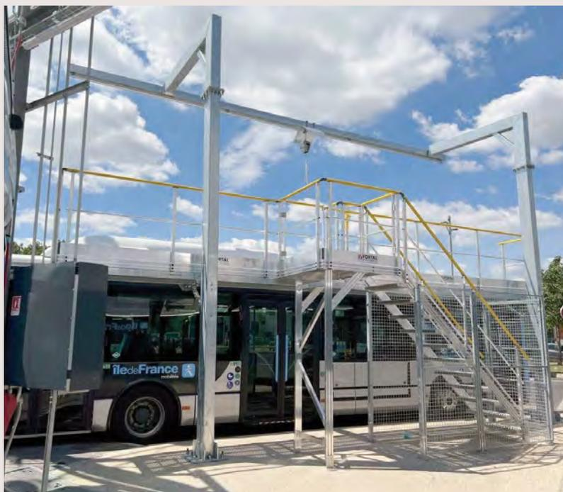
Structure fixe extérieure pour accès toiture bus à hydrogène
