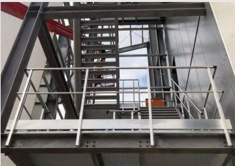
Garde-corps aluminium en kit sur structure acier existante
